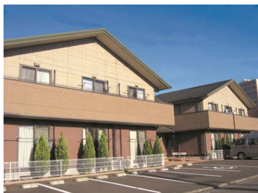
グランマ八王子 全景
